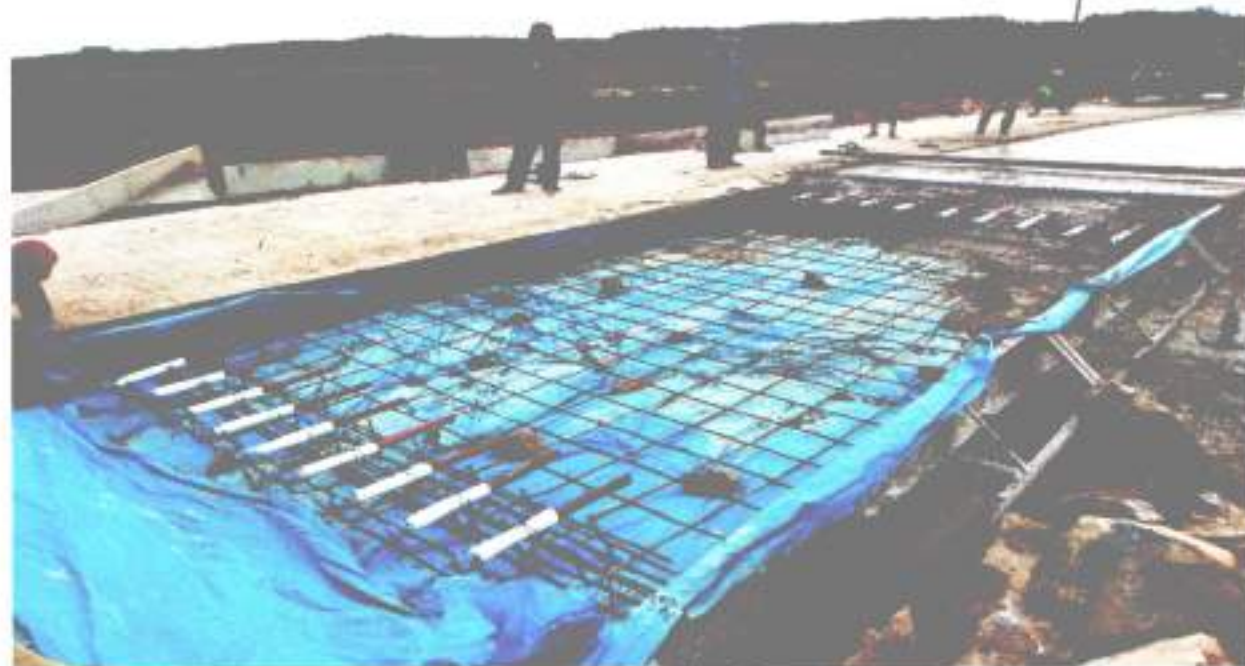
Dokumentasi Perbaikan Jalan
