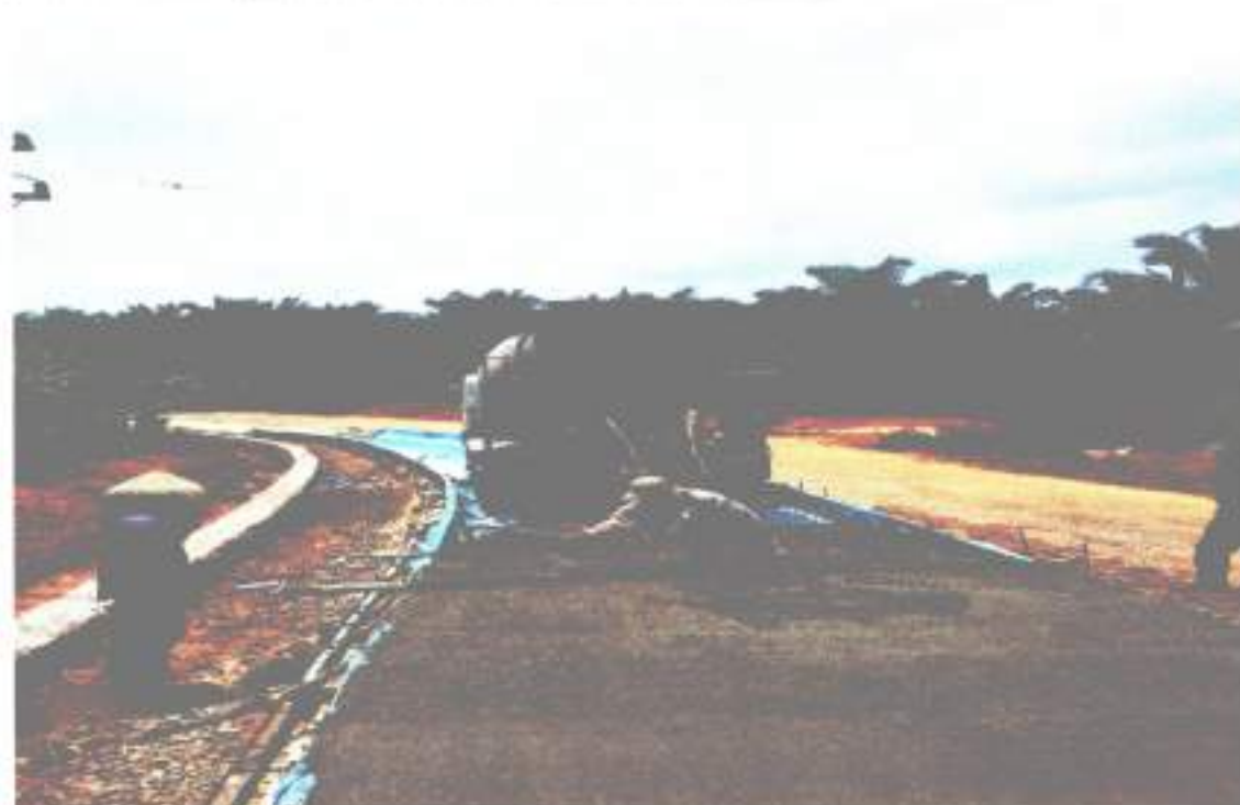
Dokumentasi Perbaikan Jalan
