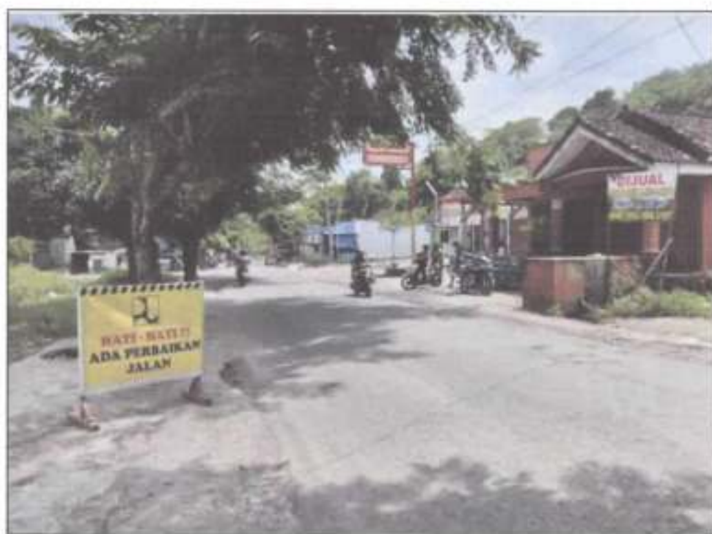
Dokumentasi Perbaikan Jalan
